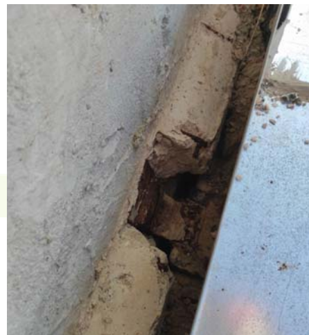
Anclaje paneles con forjado s/catas existentes
