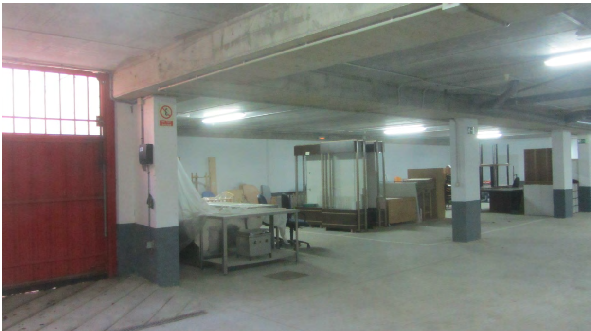
Zona de aparcamiento destinada en la actualidad a almacén de muebles, maquinaria...
