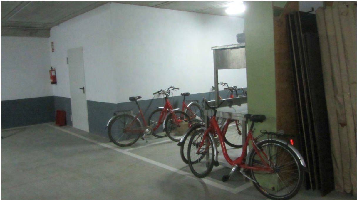
Zona de cuarto de Cuadro General de Baja Tensión
