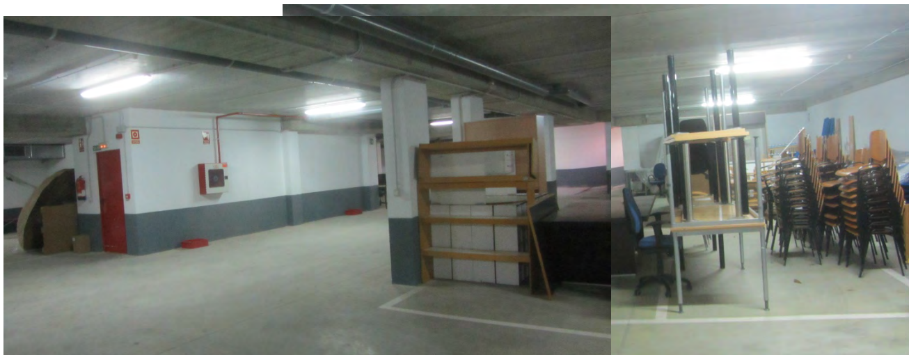
Zona del garaje que se va a destinar a guardar documentos del archivo municipal vista desde el cuarto general eléctrico.
