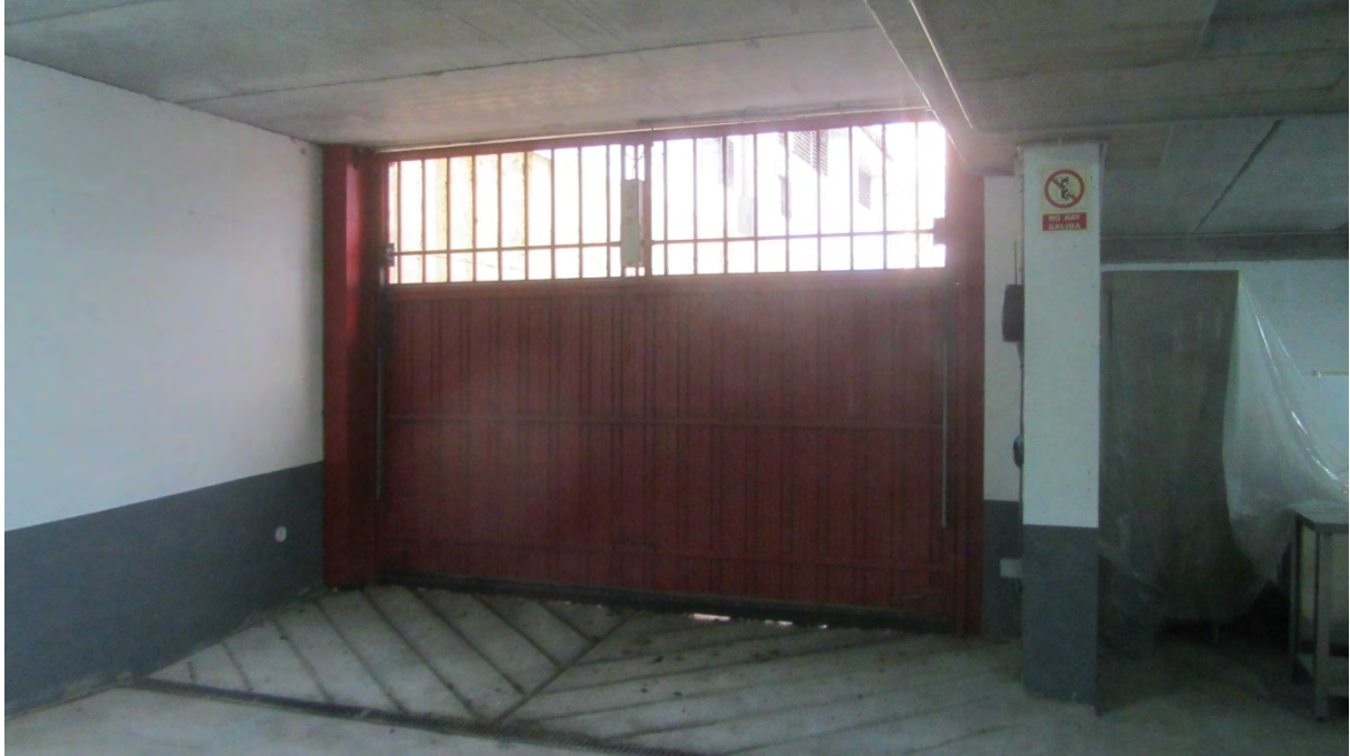
Vista del acceso rodado desde la rampa a la calle Duque de Frías
