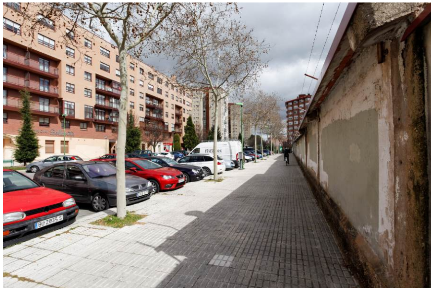
Vista general de la acera sur de la Calle Severo Ochoa.
