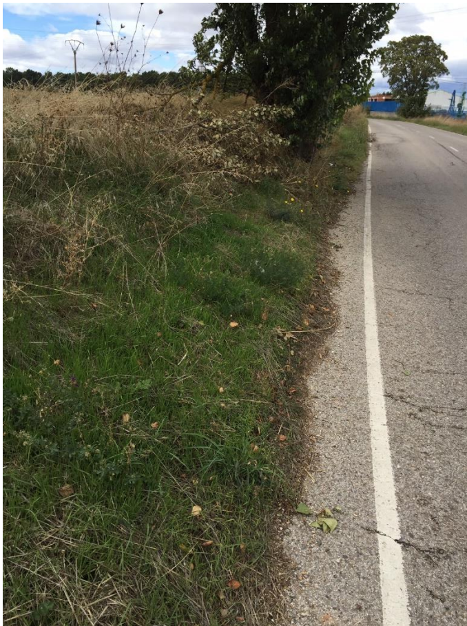
8. Detalle de cuneta en carretera de Cortes CL-8020
