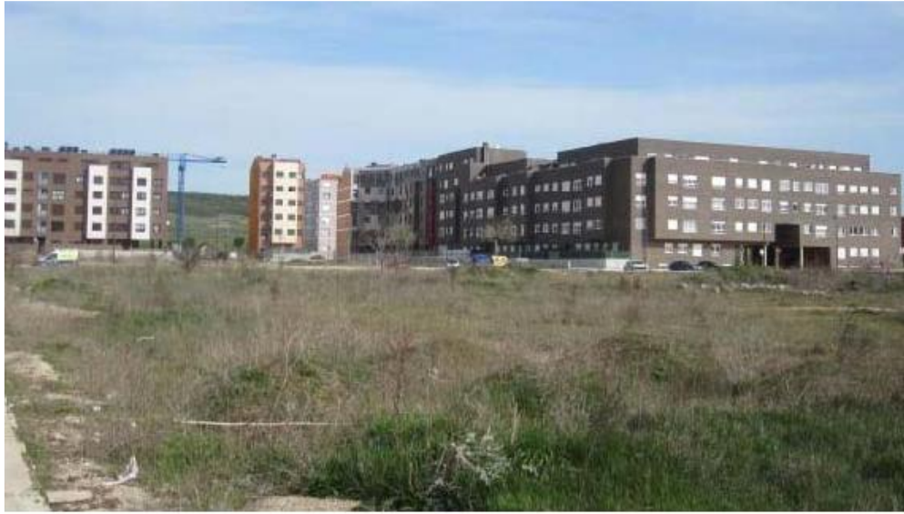
FOTO 3 (VISTA DE LA CALLE CONDE LUCANOR AL FONDO)
