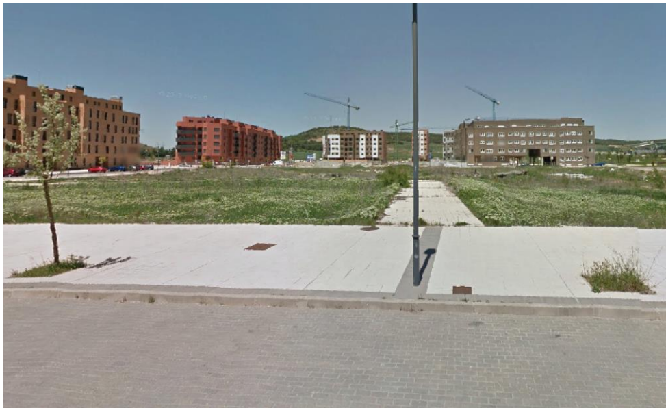
FOTO 4 (VISTA DESDE LA CALLE LAZARILLO DE TORMES)
