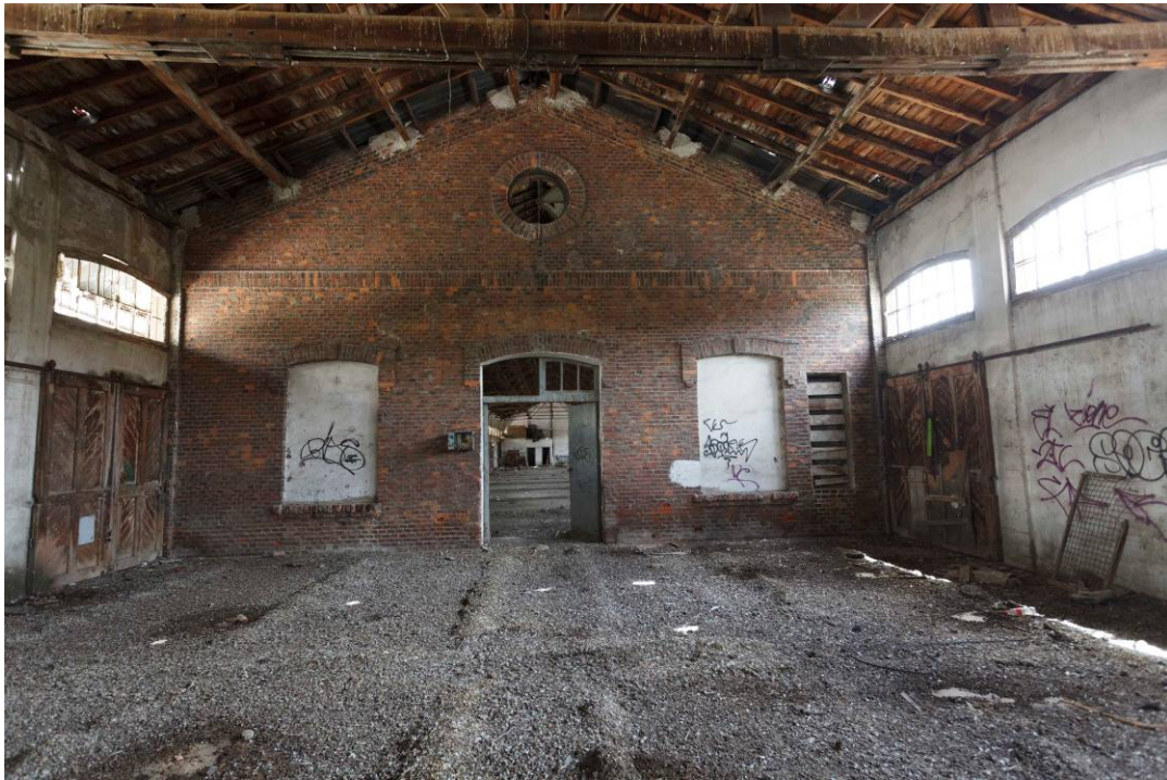
Fachada principal de la nave original, hoy en el interior de la zona de nave posteriormente ampliada
