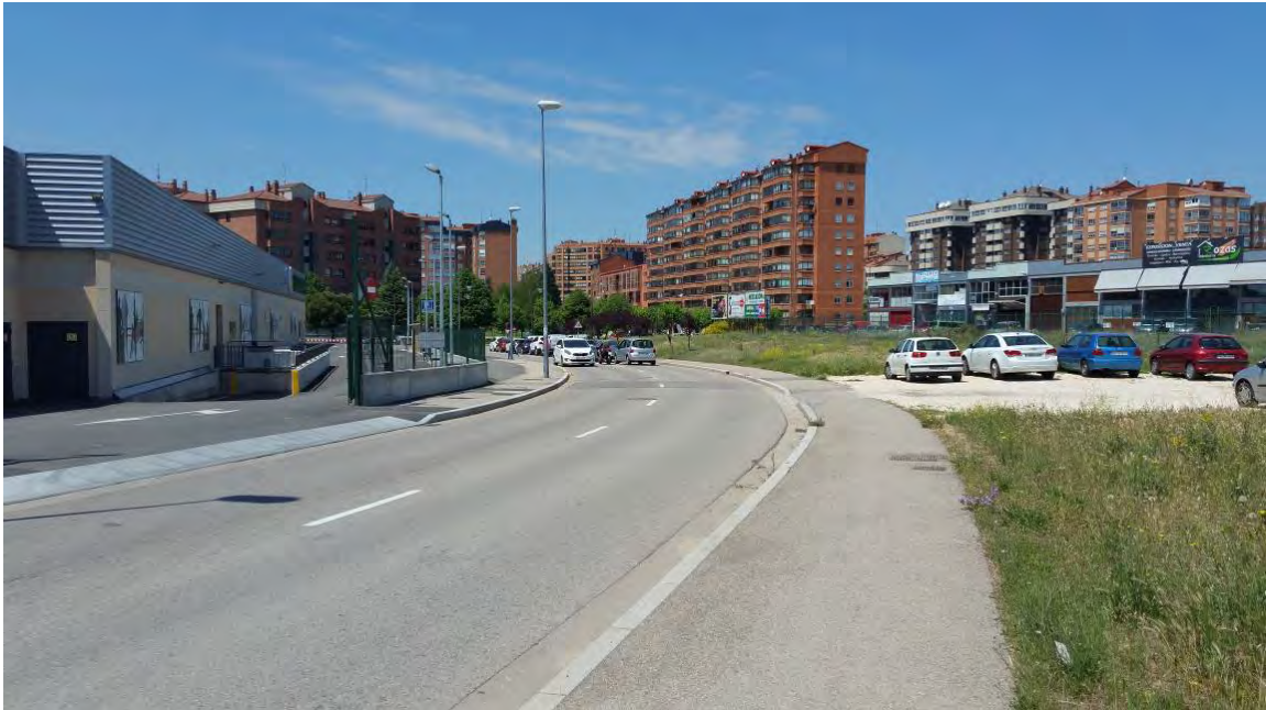
Vista del vial existente al Sur de la parcela (acceso)
