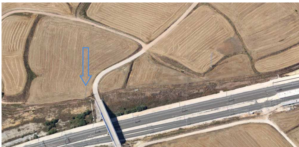
Torre de electricidad donde se conecta la red de Iberdrola.
