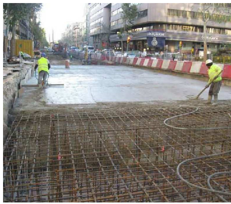
hormigonado de la losa de cubierta
