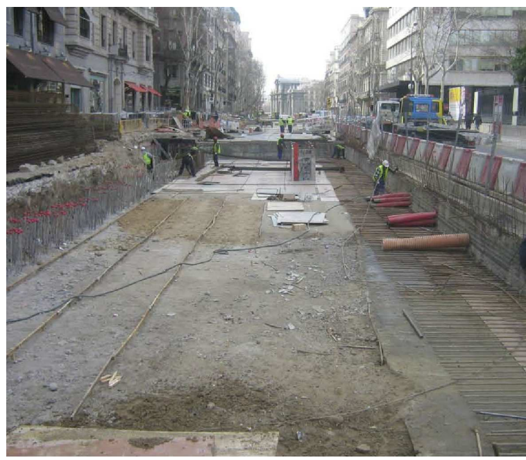
excavación de la losa de cubierta
