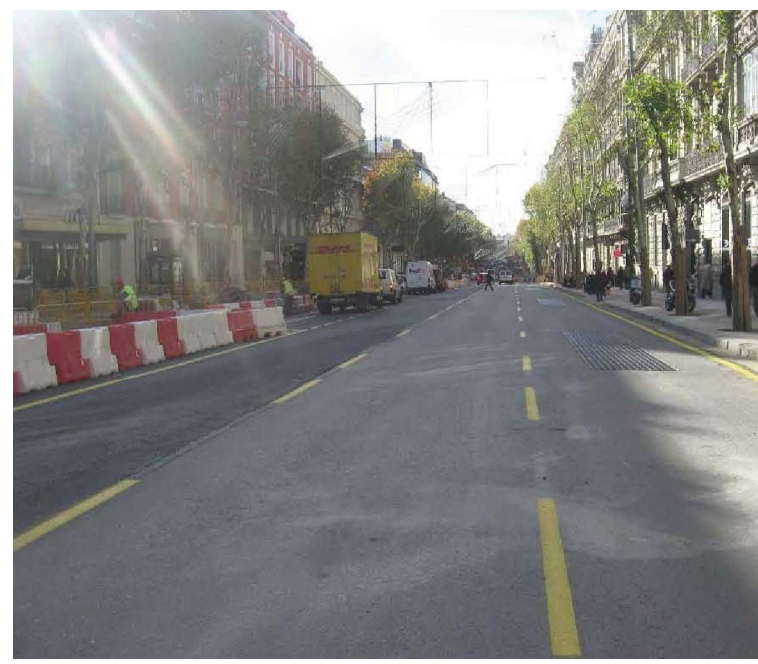
urbanización provisional y apertura al tráfico
