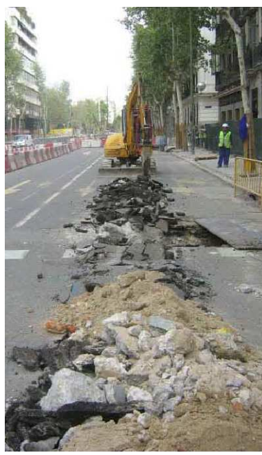
construcción de pantallas
