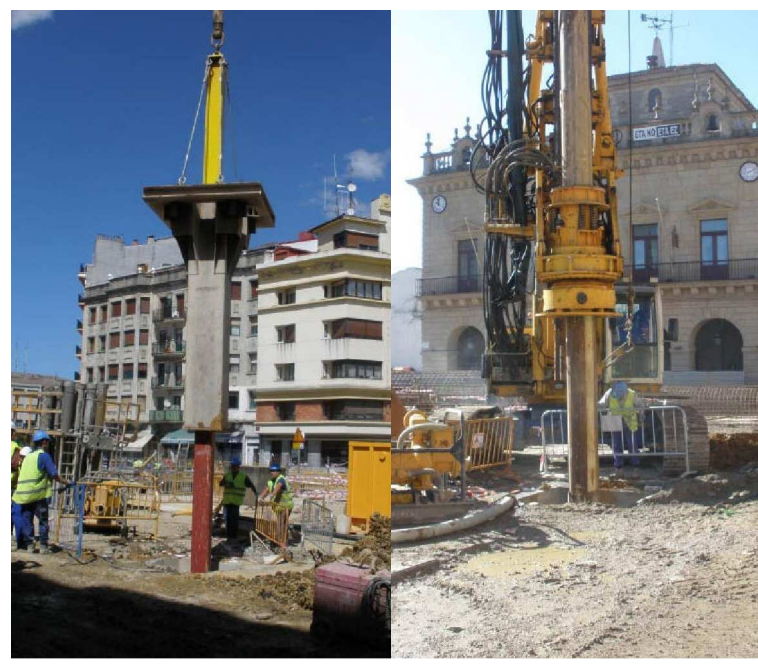
hincia de pilas-pilotes
