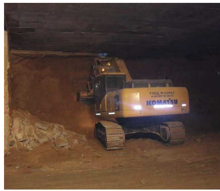
excavación en mina
