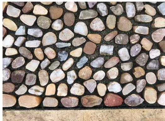
Proceso de ejecución del pavimento de canto rodado pulido y primeras pruebas del acabado final
